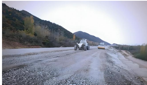
图1：公路工程填石路基现场施工图
