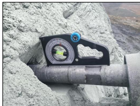
图 1.1-1 角度靠尺量测照片
