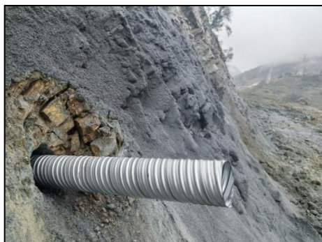
图 1.1-2 套管检验顺直度照片
