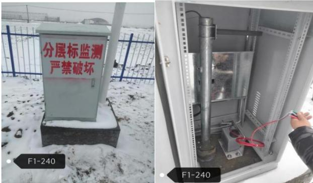
图 3 地基分层沉降、地下水位变化监测点位现场
