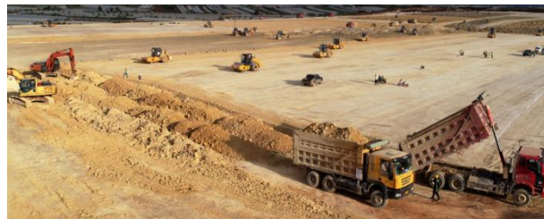
图2 云南某运输机场工程现场施工实拍图
