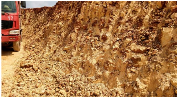
图1 云南某运输机场工程现场实拍图
